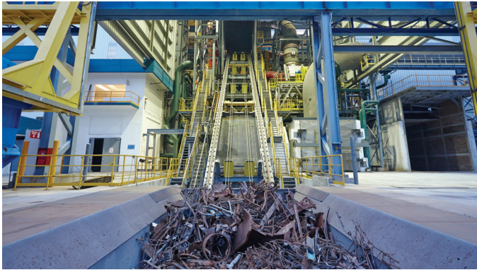
Автоматизированная система завалки лома с помощью подъемной системы
