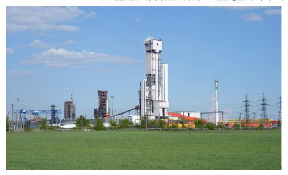
ロシア・ベルゴロド地方グブキン市のレベジンスキー製鉄所ミドレックス直接還元 HBI プラント(正面が新設のミドレックス HBI-3、中央がミドレックス HBI--2、背後が HYL HBI-1)。プライメタルズとミドレックス社が共同で建設し、同型式の単体モジュールとしてはロシア最大で、性能保証試験を完了。
