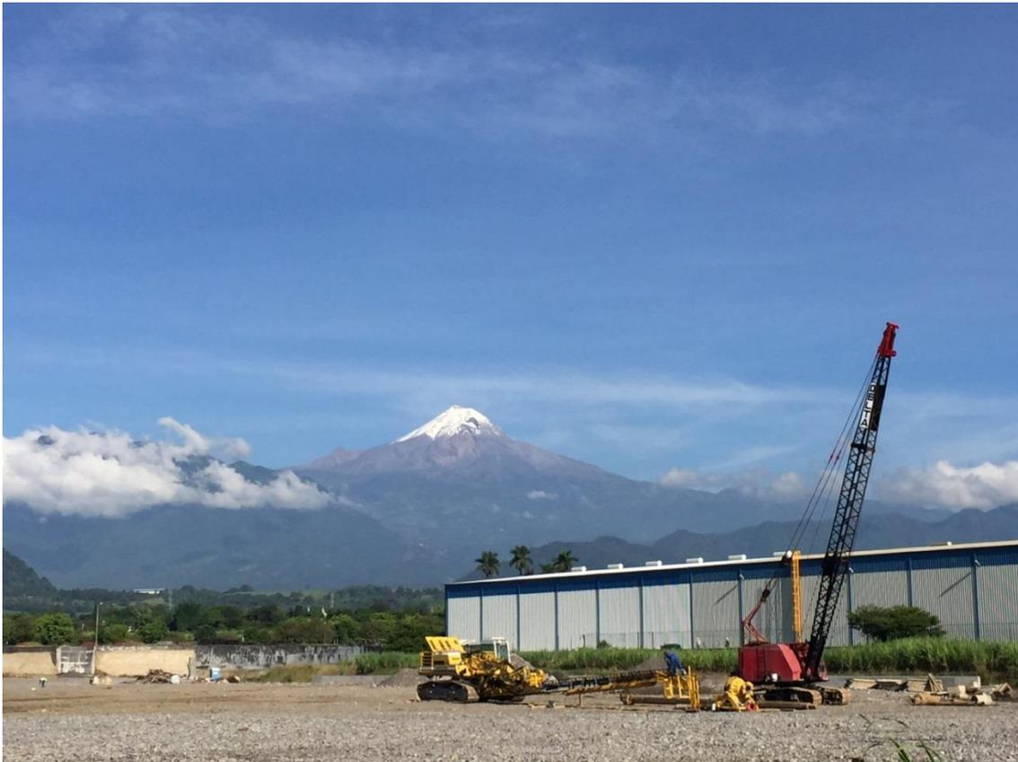
Obras de escavação para o primeiro pier na usina da Tyasa para a linha combinada de galvanização e de revestimento colorido.
