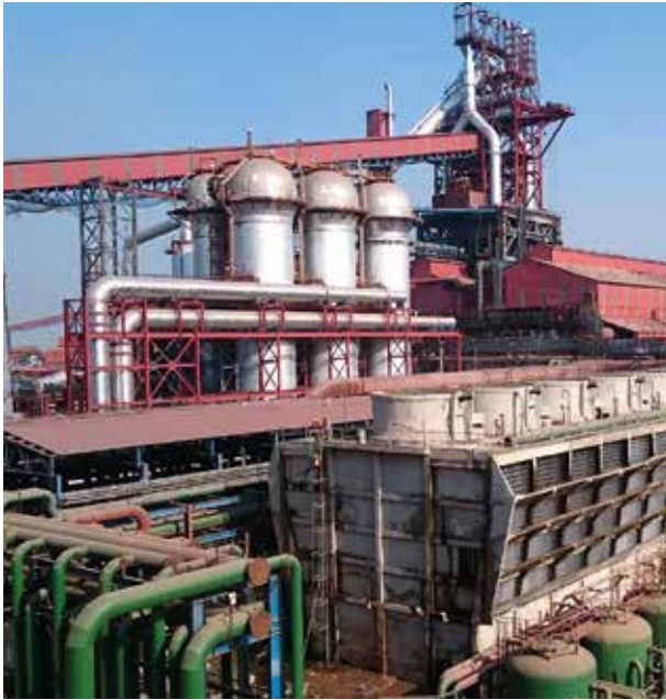
塔塔钢铁有限公司Kalinganagar钢铁厂新建1号高炉——印度最大的高炉
