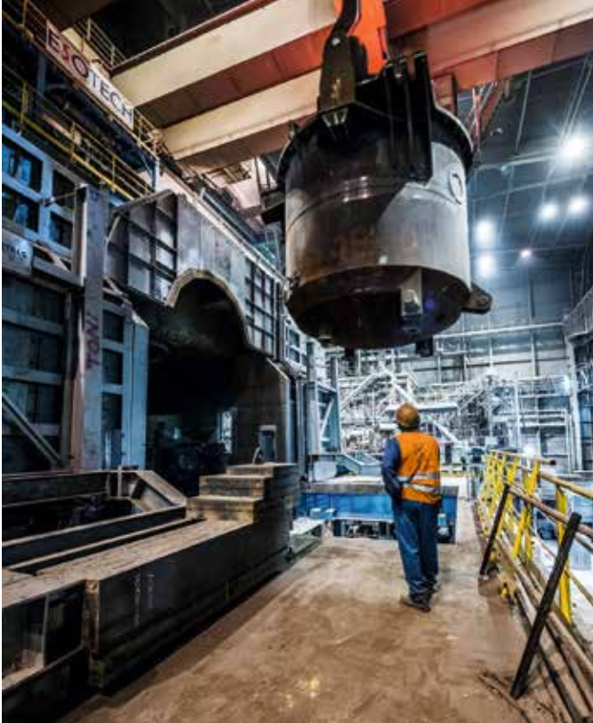
AOD炉壳正在被吊装就位。新项目的所有工作都在正常生产过程中完成。
