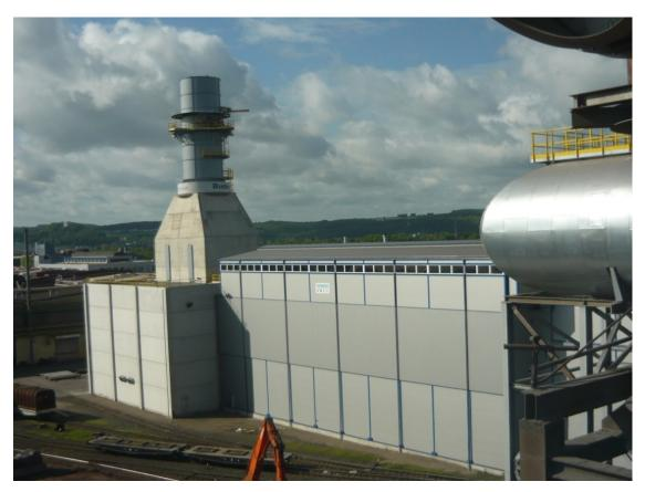
普锐特冶金技术为 Buderus Edelstahl 有限责任公司德国 Wetzlar 厂提供的室外除尘系统。它的净化能力为每小时 240 万立方米,是世界上最大的同类设备之一。净化后的气体含尘量达到每标准立方米 1 毫克以下。
