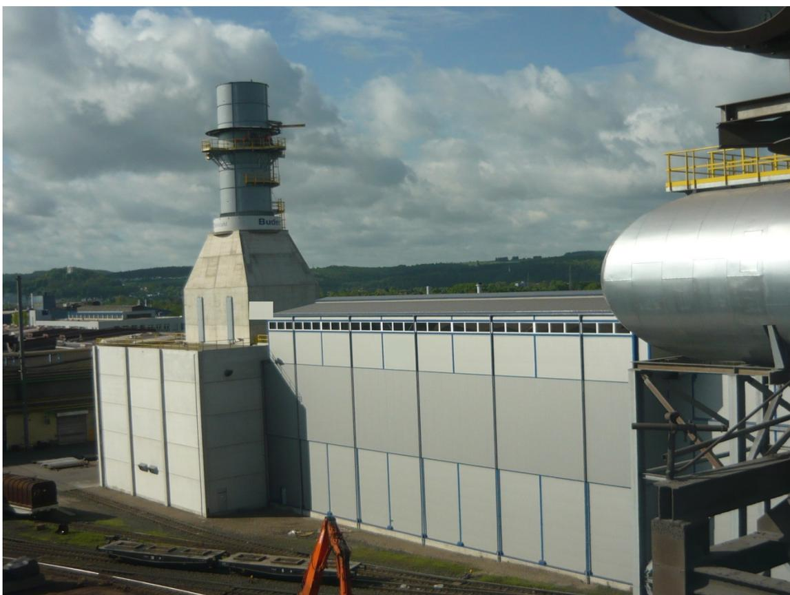
Außenanlagen der neuen Entstaubung von Primetals Technologies bei der Buderus Edelstahl GmbH in Wetzlar, Deutschland. Mit einer Reinigungsleistung von 2,4 Millionen Betriebskubikmetern pro Stunde ist sie weltweit eine der größten ihrer Art. Erreicht wird ein Reingasstaubgehalt von weniger als einem Milligramm pro Normkubikmeter.
