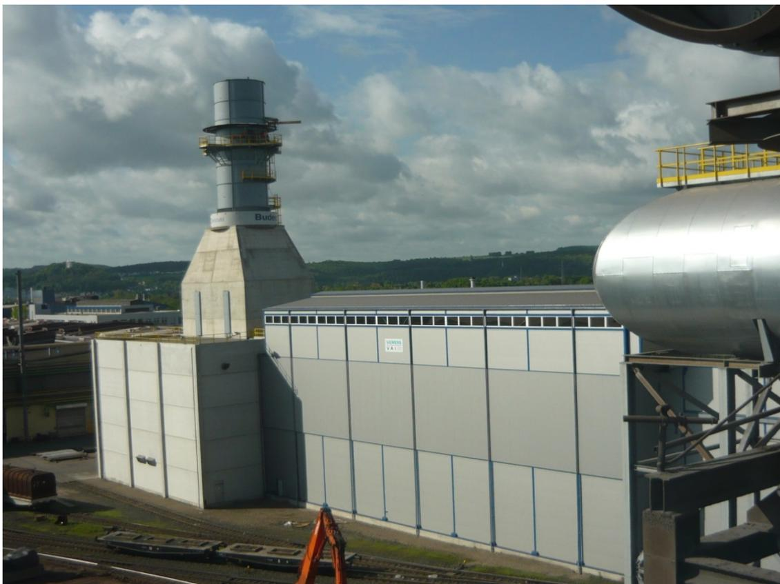
Instalações de despoeiramento externas da Primetals Technologies no site da Buderus Edelstahl Wetzlar GmbH na Alemanha. Com uma capacidade de limpeza de 2,4 milhões de metros cúbicos de trabalho por hora, é um dos maiores sistemas de seu tipo no mundo. Ele
