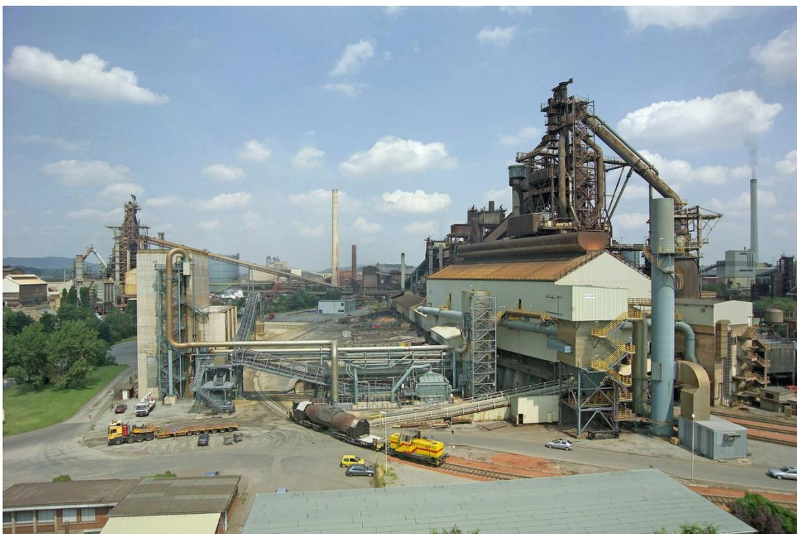
Доменная печь №4 на чугунолитейном заводе ROGESA Roheisengesellschaft Saar mbH в г.Диллинген, Германия. Одновременно с заменой футеровки доменной печи компания Primetals Technologies обновит электрическое, измерительное, аналитическое оборудование, а также оборудование системы автоматизации.
