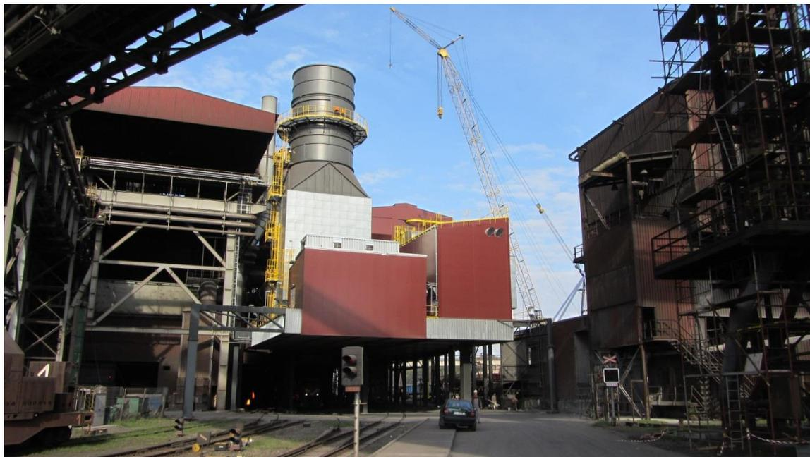
Neue Sekundärentstaubungsanlage von Primetals Technologies für zwei Konverterlinien und Nebenanlagen im Stahlwerk von Třinecké Železárny, a.s. im Konverterstahlwerk in Třinec, Tschechische Republik
