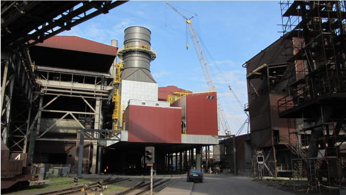
Novo sistema de despoejamento secundario da Primetals Technologies para dois convertedores e equipamento de planta secundaria na usina Třinecké Železářny, a.s. em Třinec, Republica Tcheca
