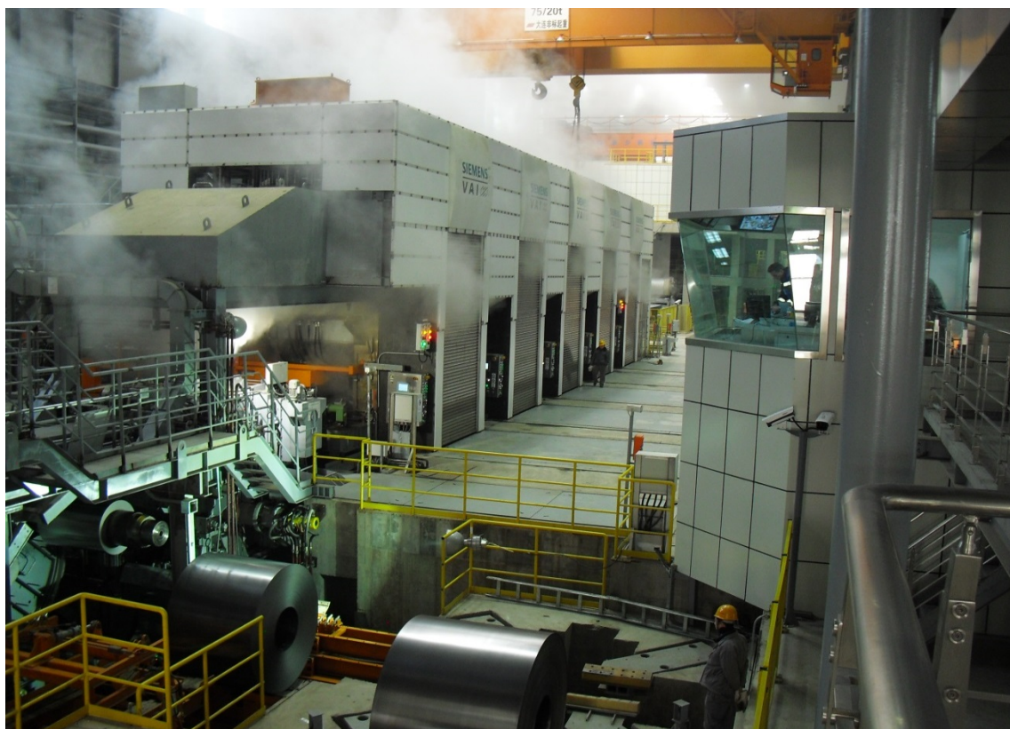
Laminação de tiras a frio da Primetals Technologies na Tangshan Iron and Steel Group Co. Ltd.
