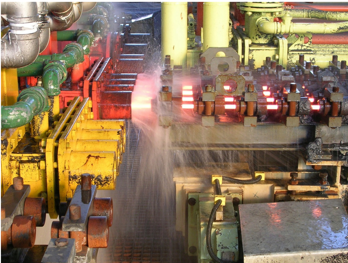
PQS-Vergütungssystem im mehradrigen Betrieb in einem Stabwalzwerk von Primetals Technologies
