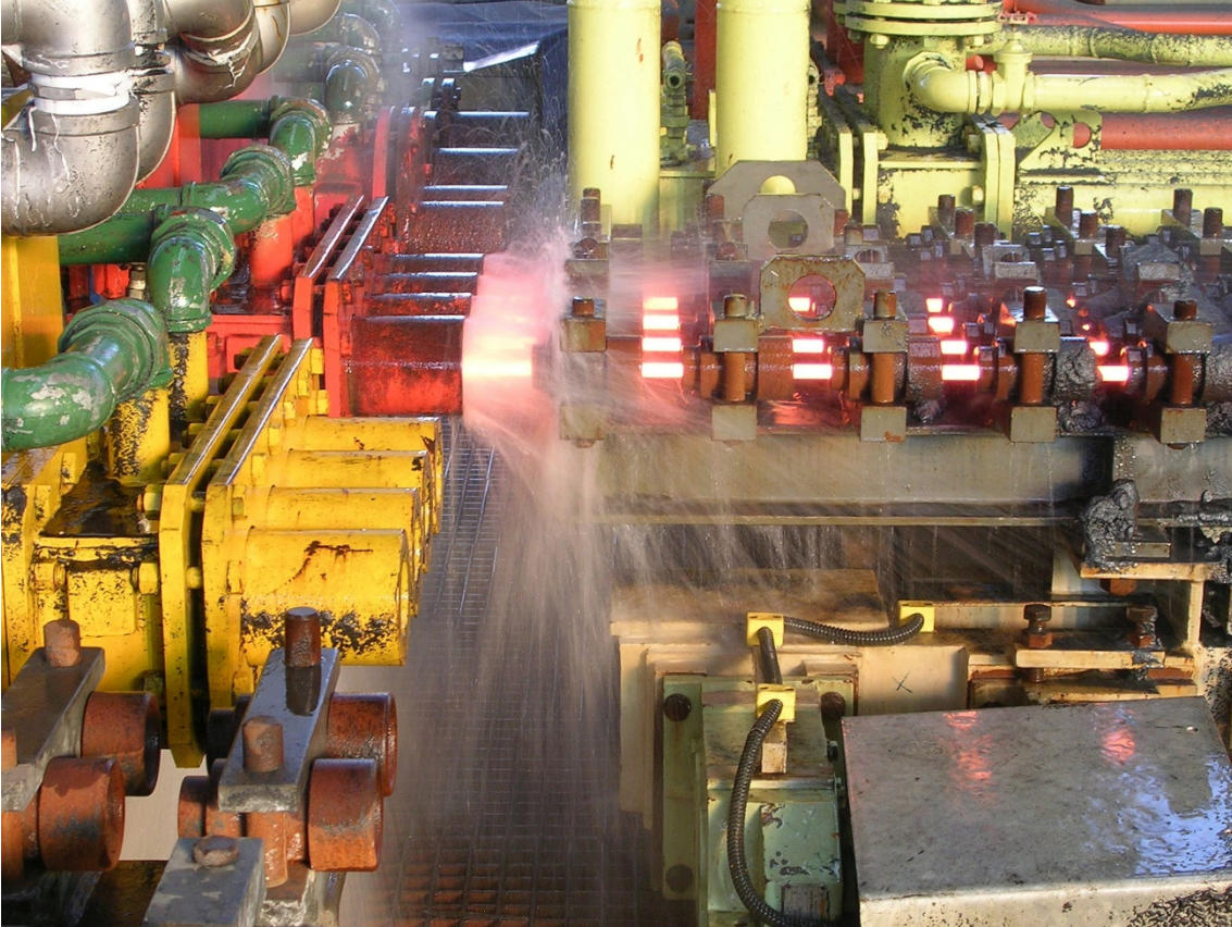
当社製棒鋼圧延機のマルチスリット ※1 操作における PQS 熱処理システム
