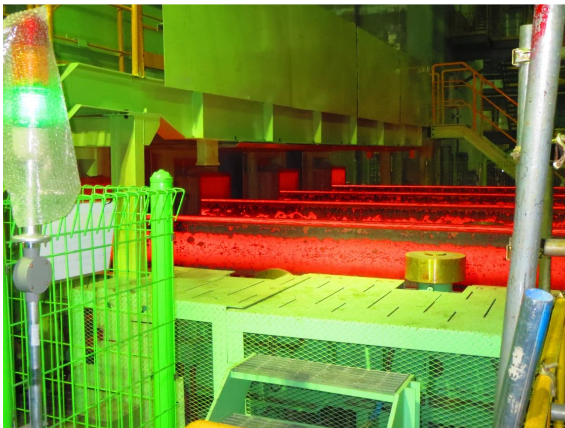
Macchina di colata continua per blumi di Primetals Technologies presso Hyundai Steel a Dangjin, Sud Corea
