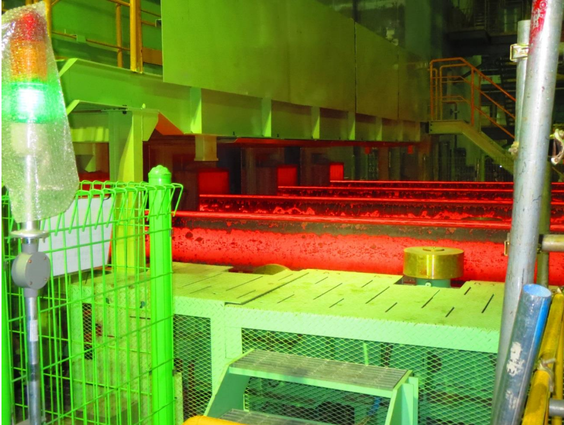
Lingotamento Contínuo da Blocos da Primetals Technologies na Hyundai Steel in Dangjin, Korea
