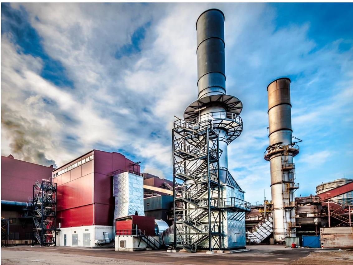
Außenanlagen der neuen Sekundärentstaubung von Primetals Technologies bei der voestalpine Stahl GmbH in Linz, Österreich. Erreicht wird ein Reingasstaubgehalt von weniger als einem Milligramm pro Normkubikmeter (Foto: voestalpine).
