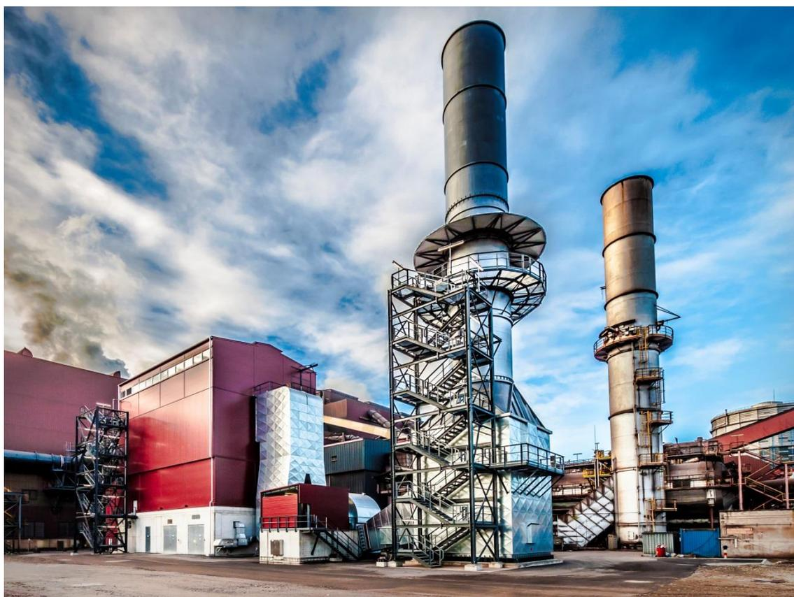
Instalações externas do novo Sistema de despoejamento secundario da Primetals Technologies na voestalpine Stahl GmbH em Linz, Austria. Ele atinge um conteúdo de particulados no gas limpo menor do que um miligrama por metro cubico padrão (foto: voestalpine).
