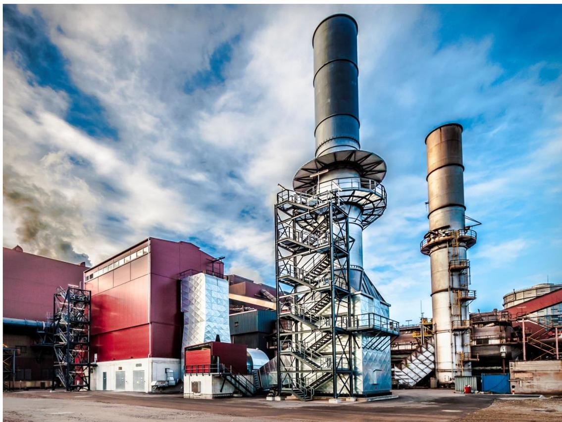
Наружные элементы системы вторичной газоочистки от Primetals Technologies на предприятии voestalpine Stahl GmbH в городе Линц, Австрия. Система вторичной газоочистки позволяет получить очищенный газ, где содержание пыли составляет менее одного миллиграмма на стандартный кубический метр (фото: voestalpine).
