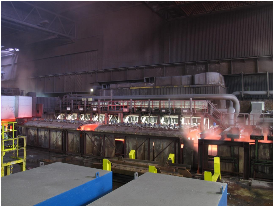
Unidade de Power Cooling em operação
