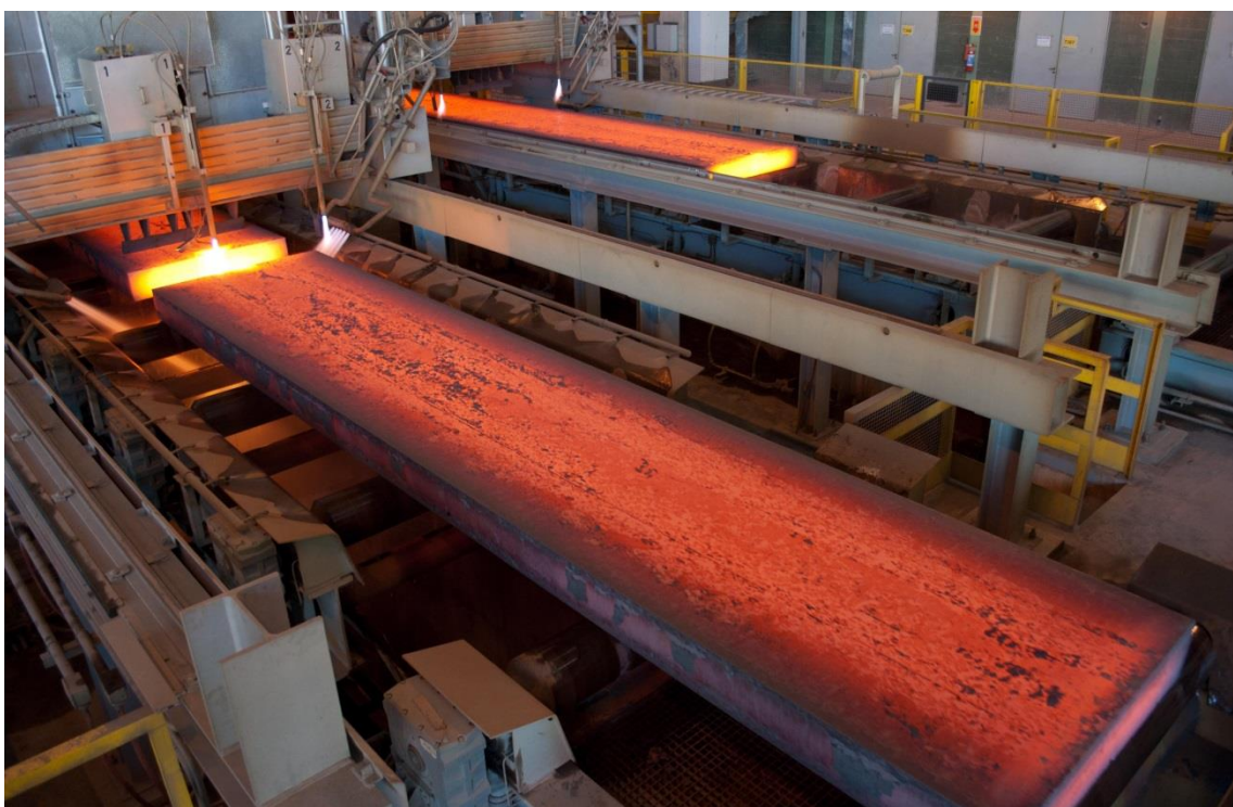
Auf einer kontinuierlichen Stranggießanlage von Primetals Technologies produzierte Brammen.
