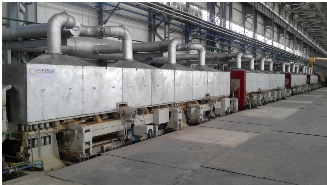
Inline-Schienenkopfhärtungssystem Idrha+ von Primetals Technologies im ARBZ-Walzwerk am Standort Aqtöbe, Kasachstan
