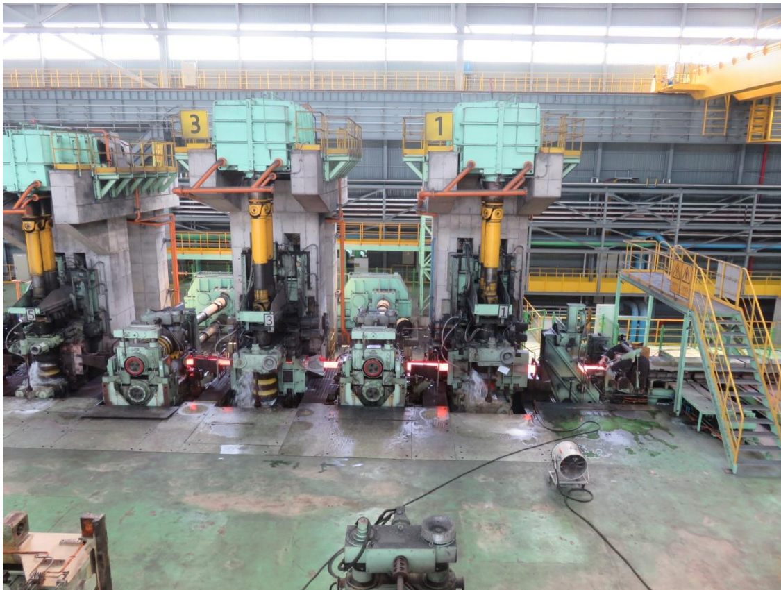
Laminador de fio máquina e barras pequenas da Primetals Technologies na Hyundai Steel em Dangjin, Coréia.
