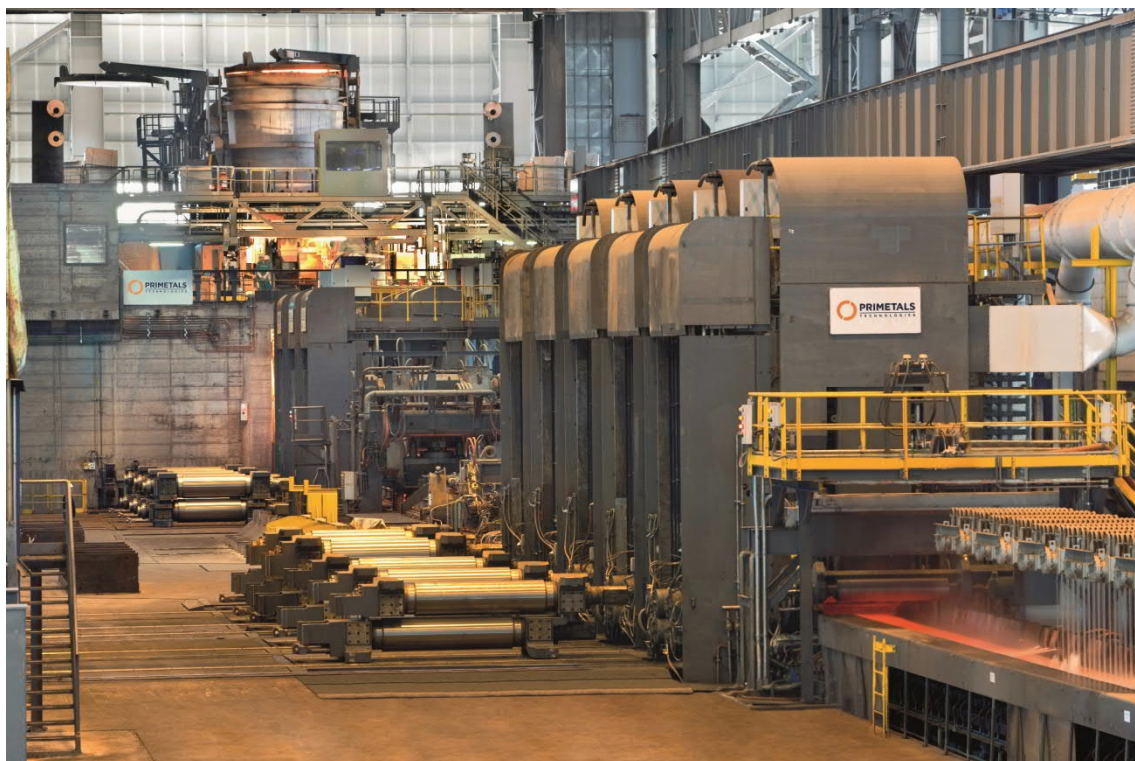
阿维迪 ESP 线正在运行中
