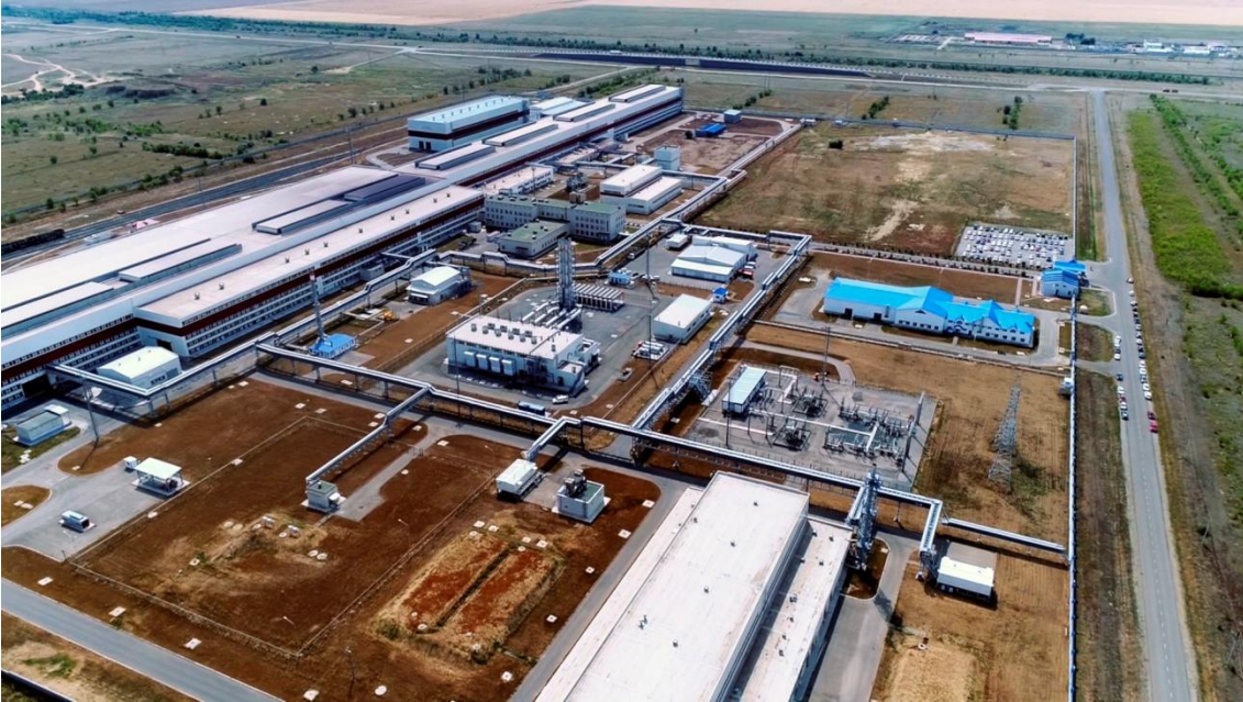
カザフスタンの ARBZ 社のレール・条鋼圧延機ライン
