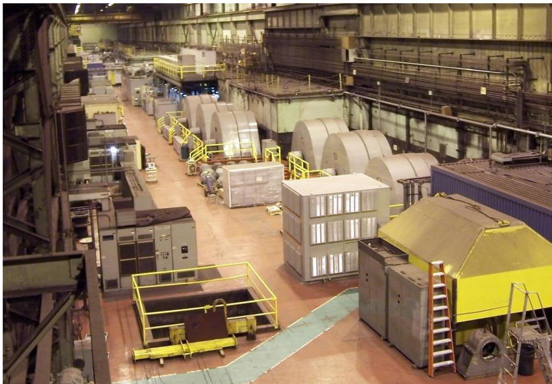
Área dos motores do laminador de acabamento da California Steel em Fontana, Califórnia (foto: cortesia da CSI).
