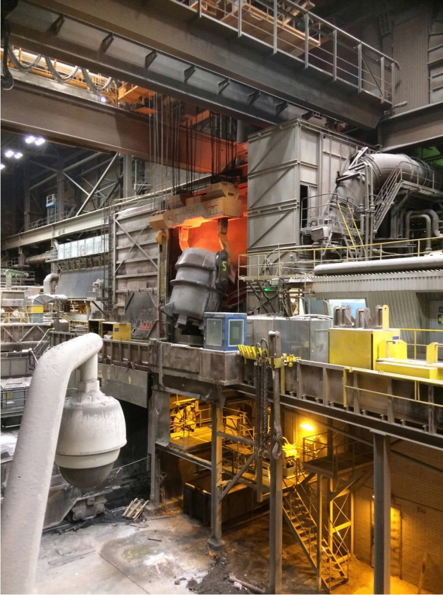
普锐特冶金技术为奥托昆普不锈钢公司芬兰 Tornio 厂改造的 AOD 转炉。
