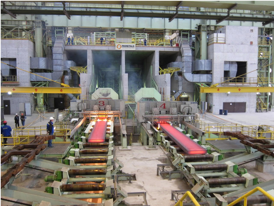
Zweisträngige Brammenstranggießanlage von Primetals Technologies
