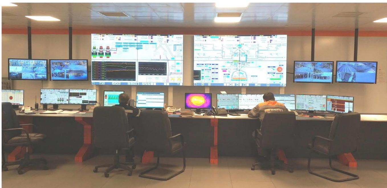
Помещение поста управления доменной печи №7 с автоматикой и электрическим оборудованием, установленным Primetals Technologies для ЕВРАЗ НТМК в Нижнем Тагиле, РФ. К середине 2020 г. Primetals Technologies также установит систему автоматизации и электрооборудование для модернизации доменной печи №6.
