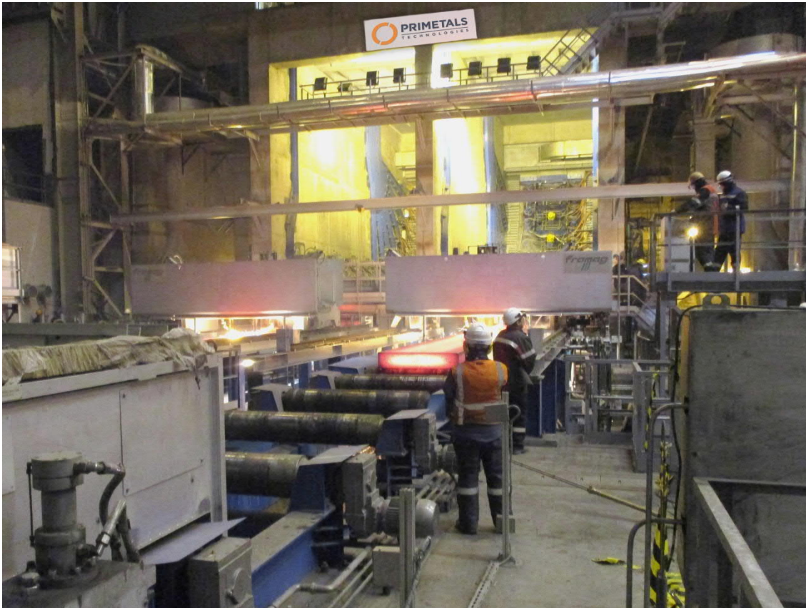
Stranggießanlage CC4 von Primetals Technologies bei PJSC „Ilyich Iron and Steel Works of Mariupol“ (MMKI), Ukraine
