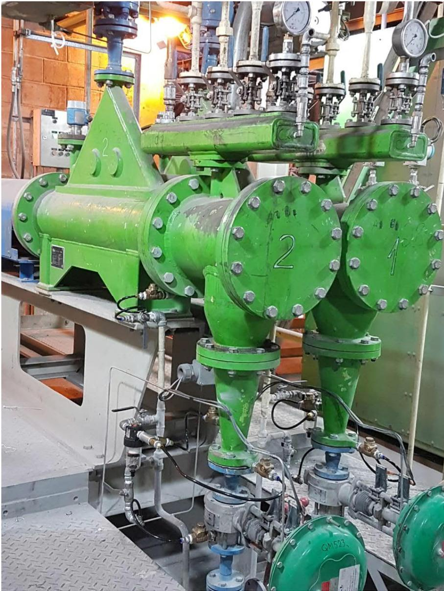
毎分 3~15 kg の速度で Mg を正確に供給する定量投入装置
