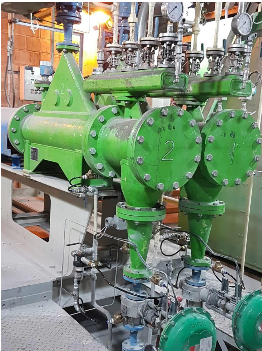
Dispositivo de dosagem volumétrica para alimentação precisa de magnésio com vazões de 3 a 15 kg/min
