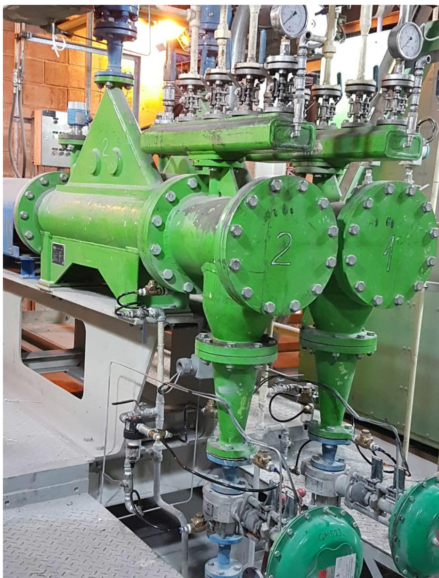
Объемное дозирующее устройство для точной подачи магния (Mg) со скоростью от 3 до 15 кг/мин
