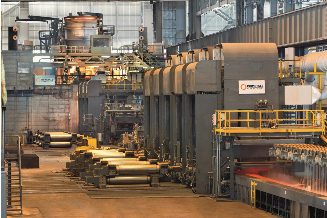
Arvedi-ESP-Anlage in Betrieb
