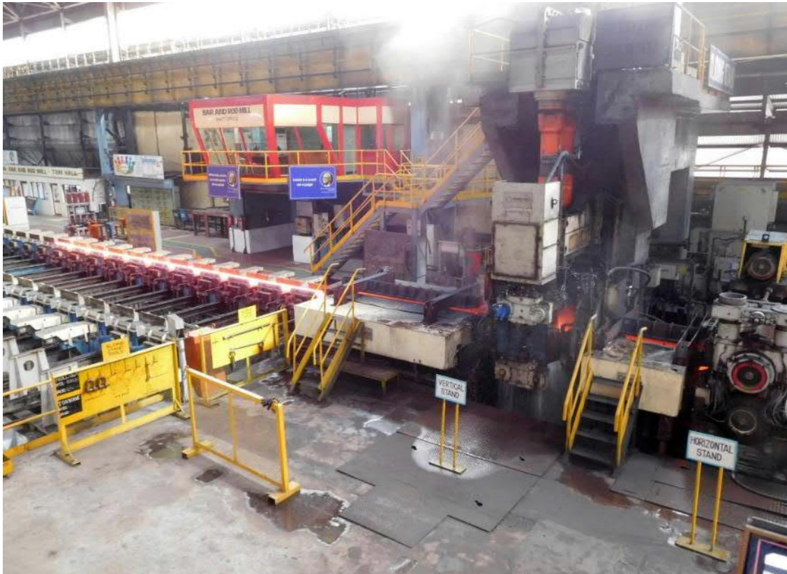
普锐特冶金技术采用新的可逆式粗轧机组改造的 JSW 钢铁有限公司印度 Salem 厂轧机
