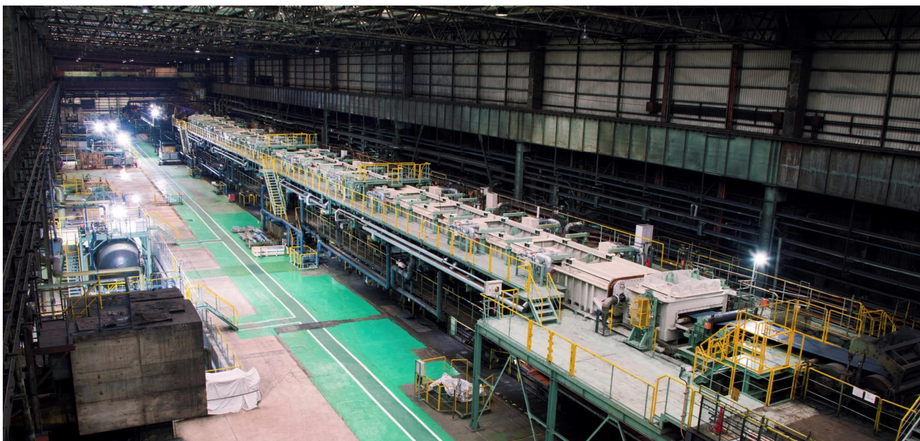
用 PP(聚丙烯)iBox 改造的酸洗线(2020 年 7 月 13 日)
