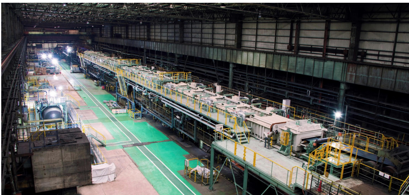
Mit der iBox aus Polypropylen modernisierte Beizanlage (13. Juli 2020)
