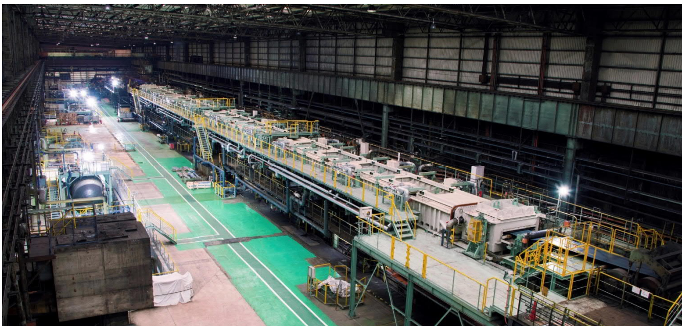
Linha de decapagem modernizada, equipada com sistema iBox de polipropileno (13 de julho de 2020)
