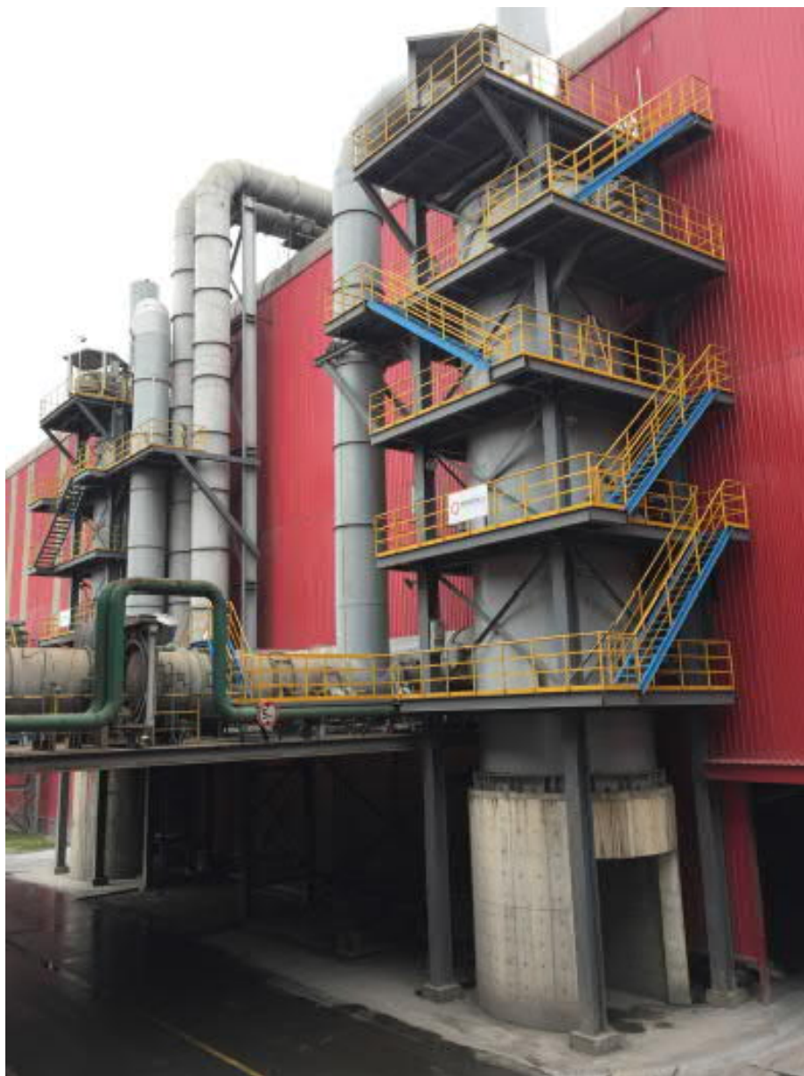
常州東方特殊鋼の転炉 No.1 および No. 2 に設置された当社の WESP タワー
