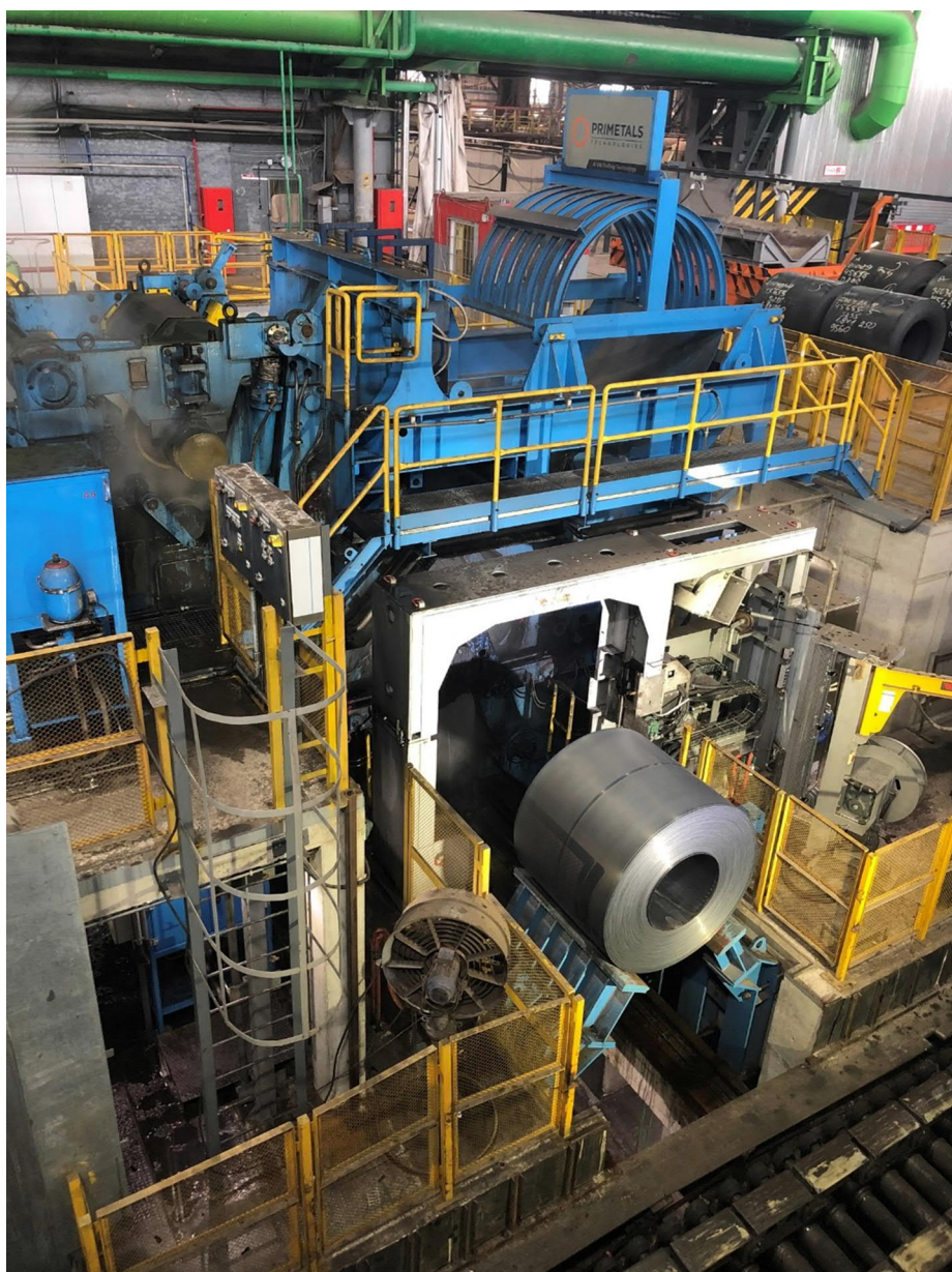
Новая моталка Primetals Technologies на СГП 1700 на ММК им. Ильича в Мариуполе
