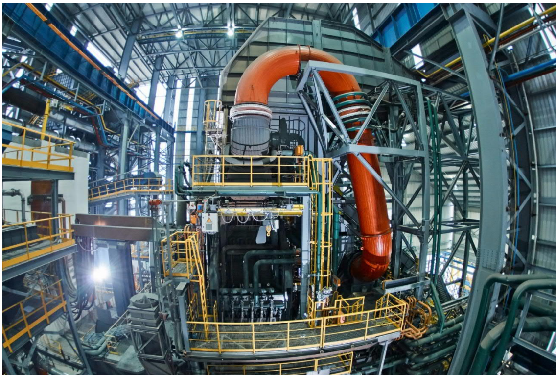
Самая современная шахтная печь ДСП Quantum от Primetals Technologies
