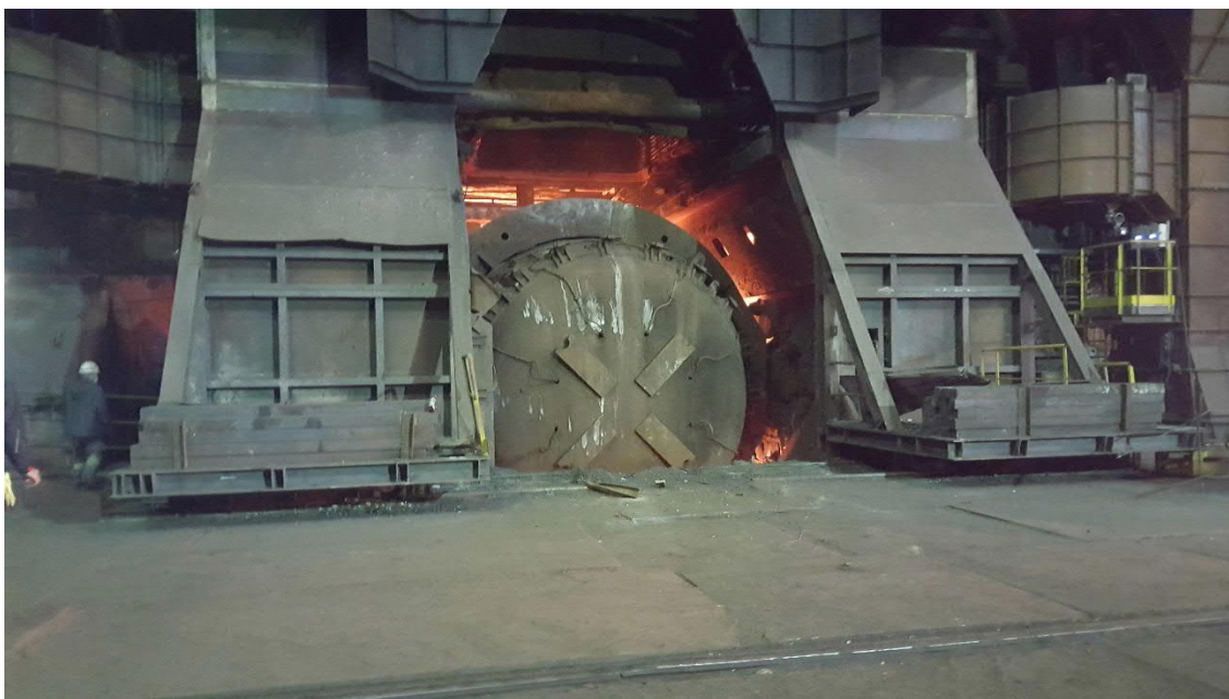
Aktueller BOF-Konverter Nr. 2 bei ArcelorMittal Zenica
