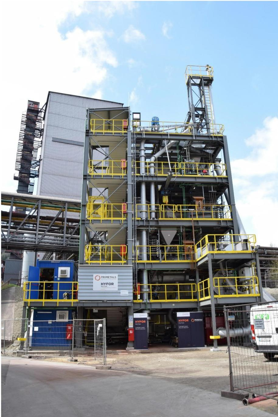
Foto der von Primetals Technologies entwickelten Pilotanlage für die HYFOR-Direktreduktion von Feineisenerzen am voestalpine-Standort im österreichischen Donawitz. Der DR-Prozess ist CO<sub>2</sub>-frei und H<sub>2</sub>-basiert.
