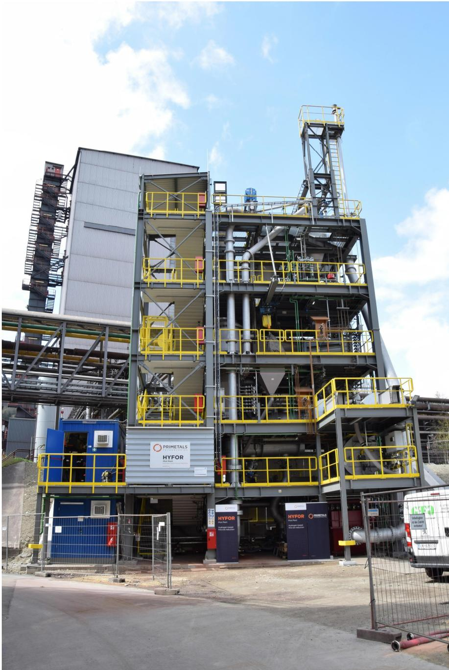
プライメタルズテクノロジーズが開発した水素ベースで CO<sub>2</sub> を排出しない微粉鉄鉱石直接還元パイロットプラント HYFOR（オーストリア、フェストアルピーネ社ドナヴィッツ製鉄所構内）
