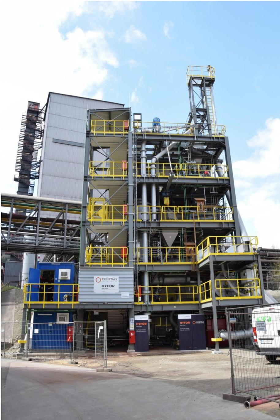
Foto da planta piloto de redução direta HYFOR para finos de minério de ferro desenvolvida pela Primetals Technologies, localizada na usina da voestalpine em Donawitz, Áustria. Usando hidrogênio como redutor, o processo de redução direta não emite CO<sub>2</sub>.
