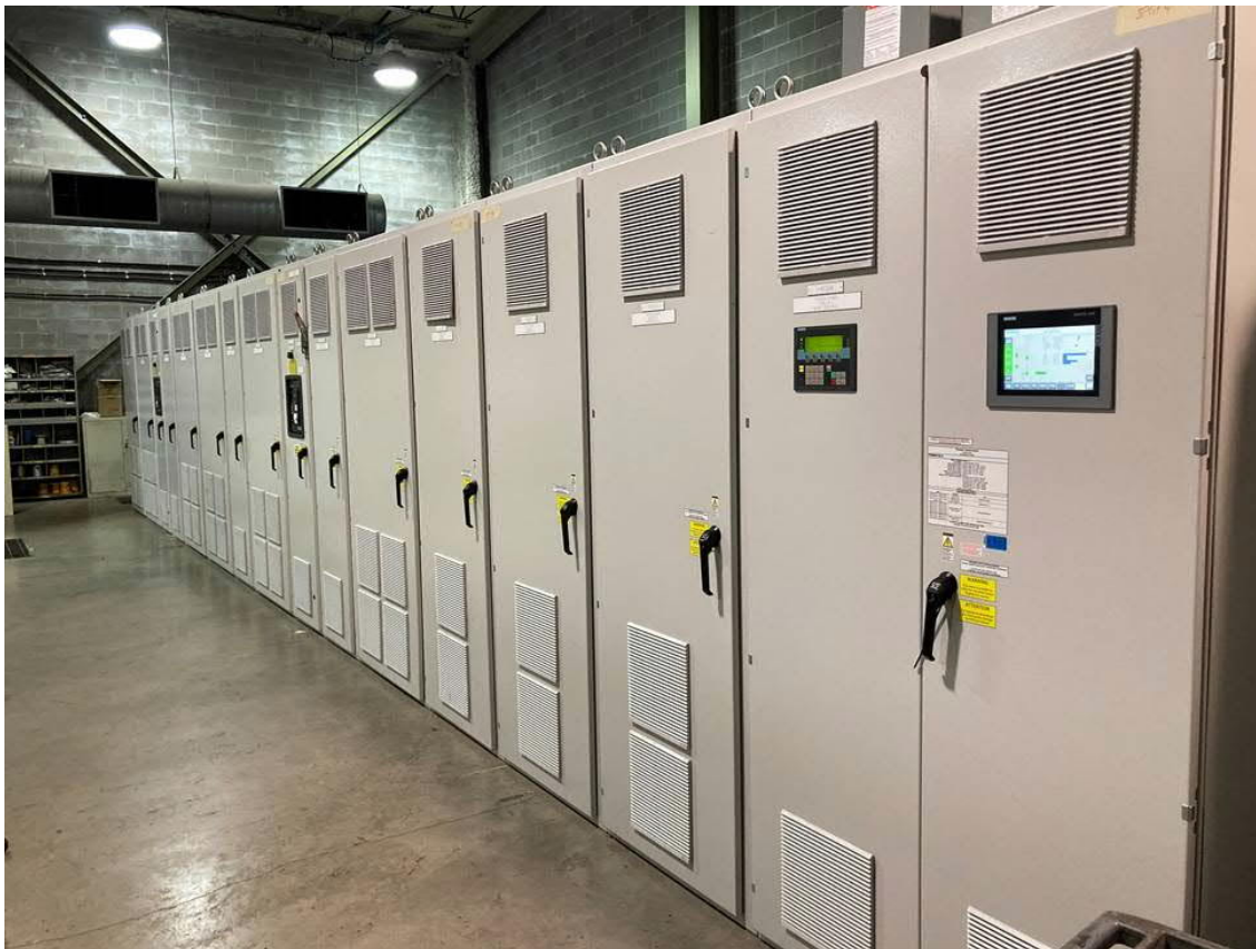
加拿大苏圣玛丽市 Algoma 钢铁公司直接带钢生产线地下卷取机的新型传动
