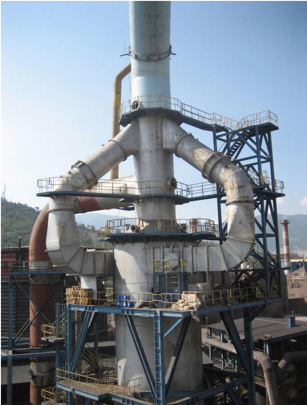
欧洲一座高炉上安装并运行的 6.5m 三进口旋风除尘器
