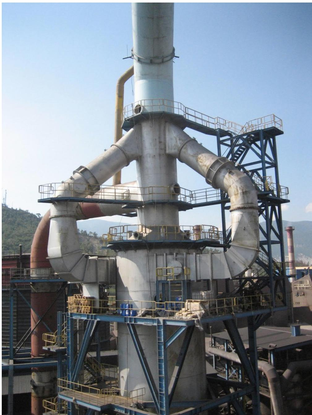
ヨーロッパの高炉に設置された稼働中の 6.5m Tri-Ax サイクロン
