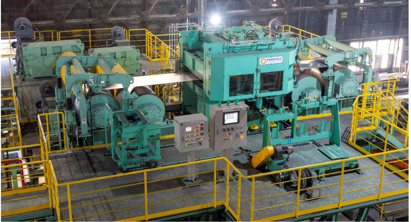
东京钢铁有限公司冈山厂安装的 50 吨张力矫直式高强钢破磷磷机
