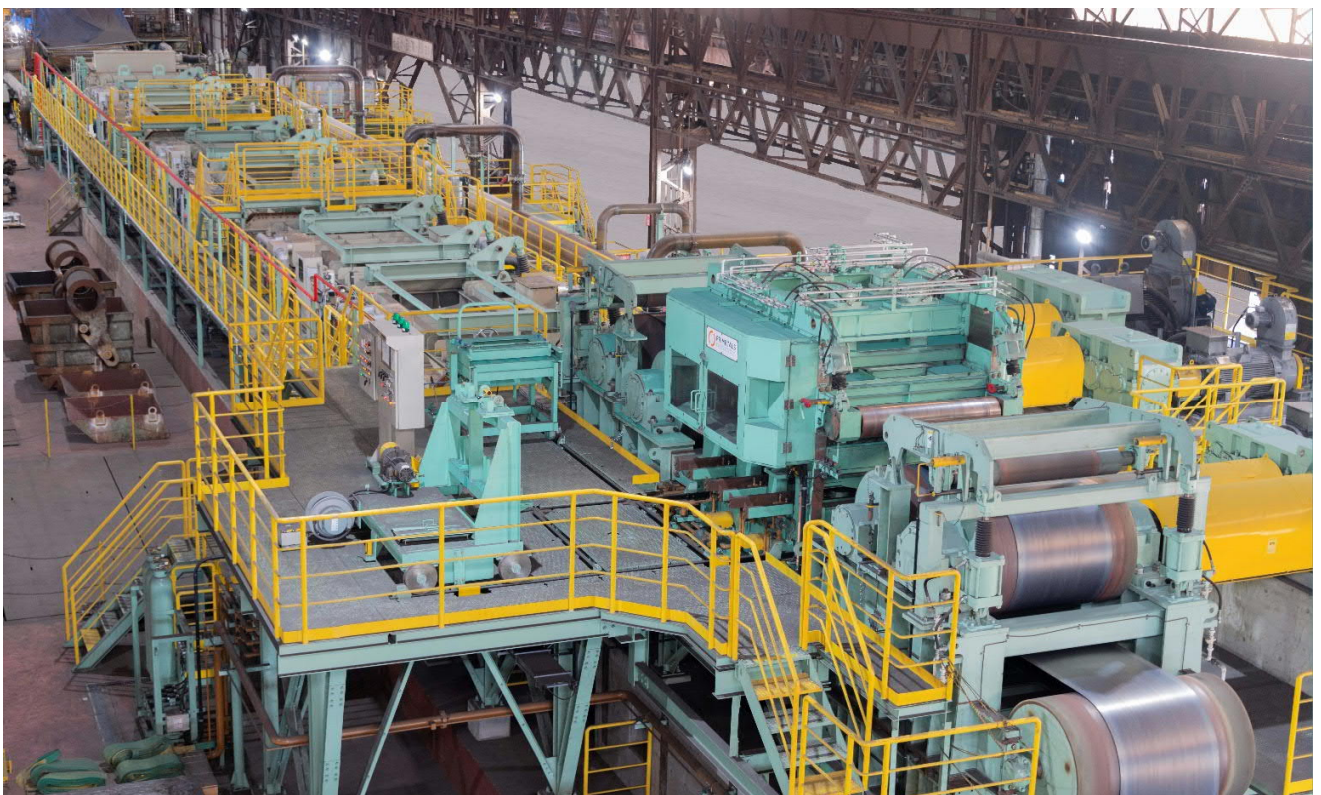
ポリプロピレン製 i Box 酸洗設備／設備更新後（2022年2月9日撮影）
